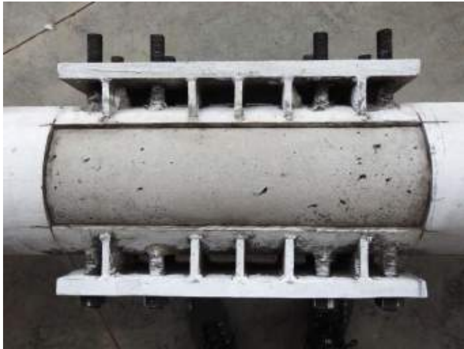
Figura 7.1-1.- Corte en columna CCCI 2-2 detalle de fisura
