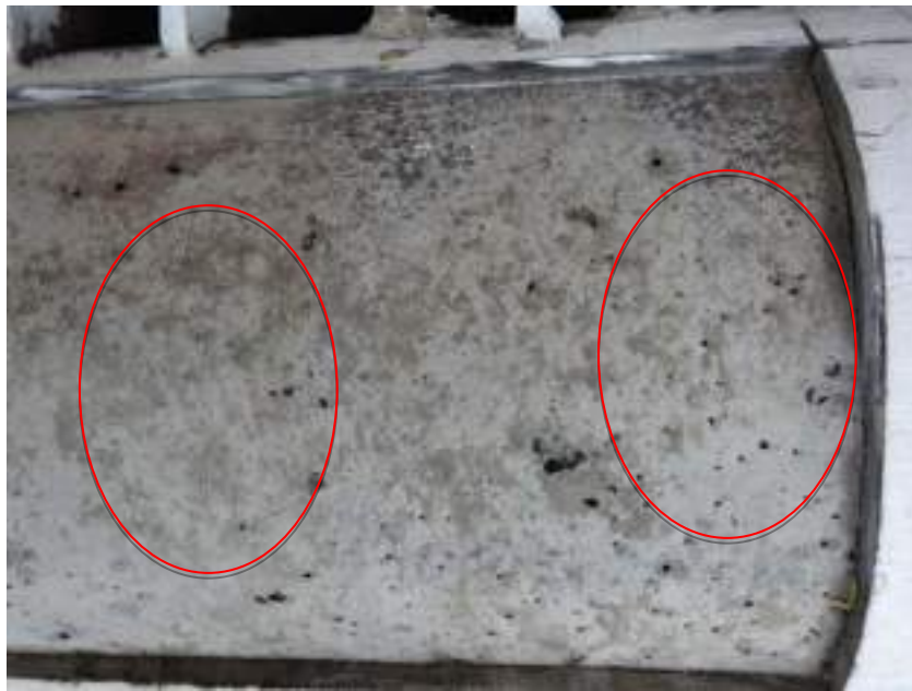
Figura 7-4.-Detalle de pequeñas fisuras en línea de acción del perno pasante para PTE D323.9x10-W18x35-1-2
