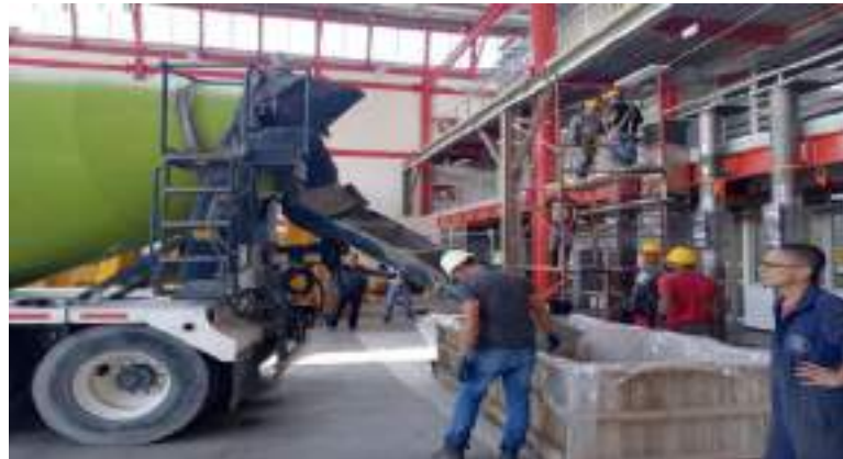
Figura 4.2-2.-Concreto premezclado de 21 MPa para columna compuesta
