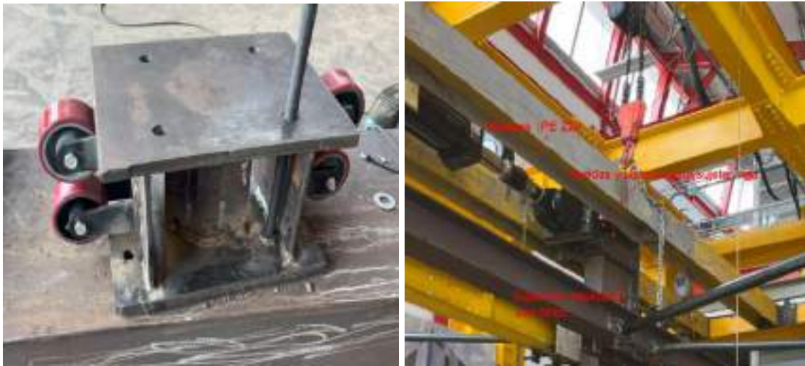
Figura 5.4-1-Figura 5.4-2.-Aditamento para sujetar viga y rodamiento del gato para empuje direccionado
