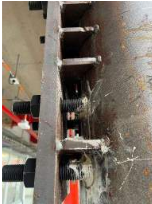
Figura 4.2-4.-Taponamiento de sobrecanchos en diámetro de perforación de pernos.
