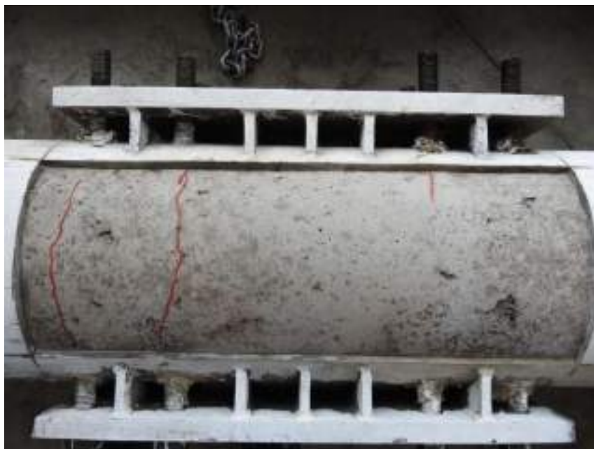
Figura 7-3.- Vista General de ventana en zona de panel para PTE D323.9x10-W18x35-1-2
