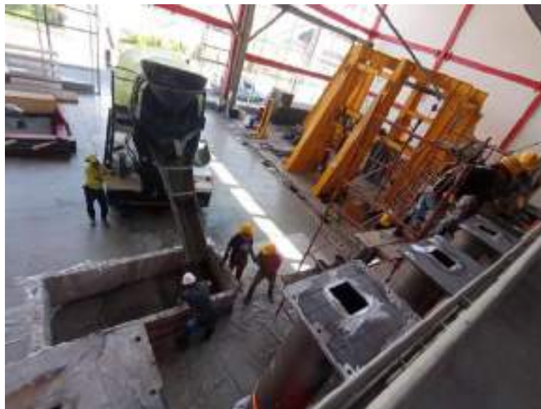
Figura 4.2-3.-Ventanas de acceso para vaciado de concreto
