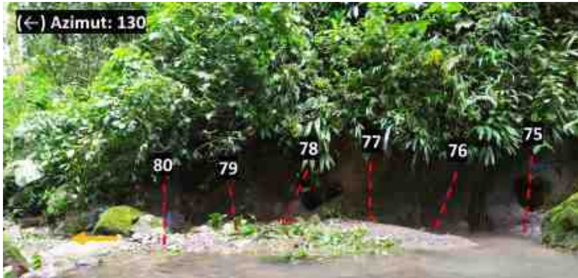
Figura 3-6. Arenitas del Segmento E. Se observan oquedades de gran tamaño (cerca a los bastones 75 y 78), acompañadas de surcos en el lecho de la quebrada, mostrando así erosión de un material disgregable. Flecha naranja indica la polaridad.
