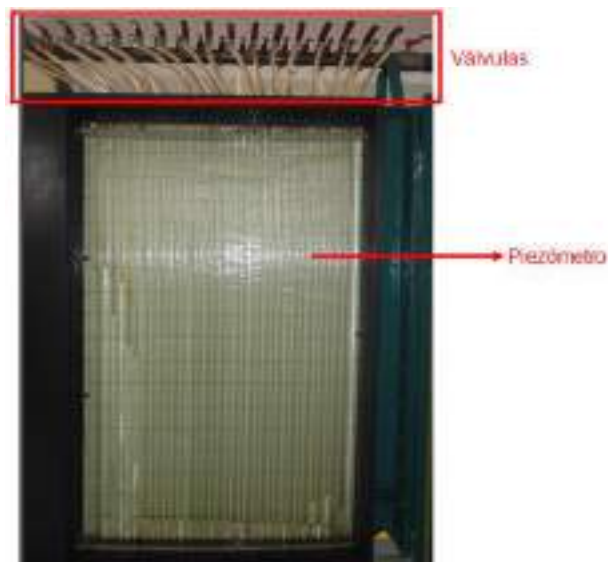
Figura 2.1-1: Válvulas de purgas y tablero de piezómetros.
