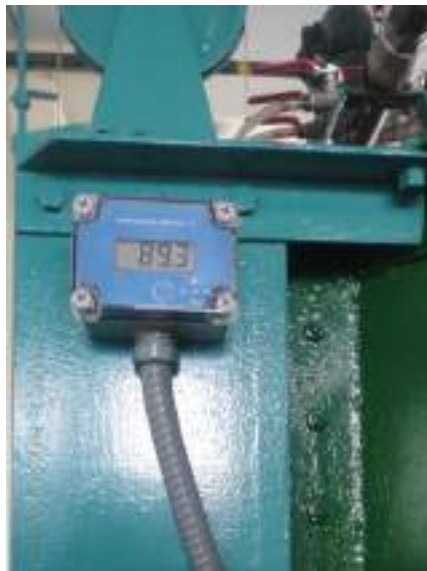
Figura 2.2-3: Sensor digital PRECISION DIGITAL modelo PD662-0K0-00, para medir la profundidad del tanque volumétrico.
