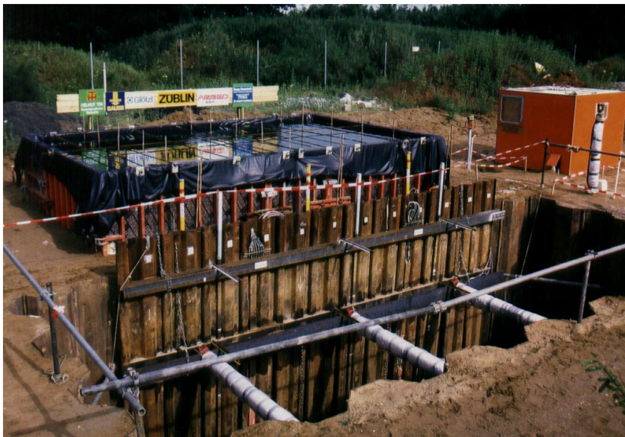
Figura 3. Ensayo a escala real en Hochstetten (Alemania) [1]
