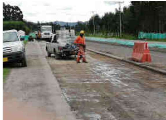
Figura 2. Humectación de capas granulares Source: Autor
