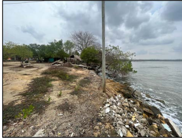
Figura 14. Árboles volcados, poca vegetación y viviendas expuestas a la erosión
