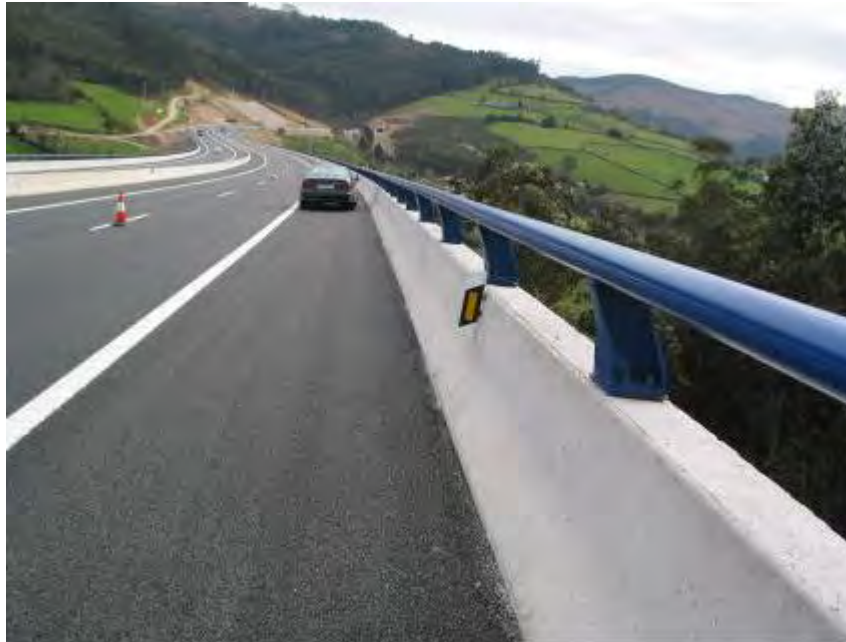
Figura 83. Barrera de concreto con barandas metálicas
