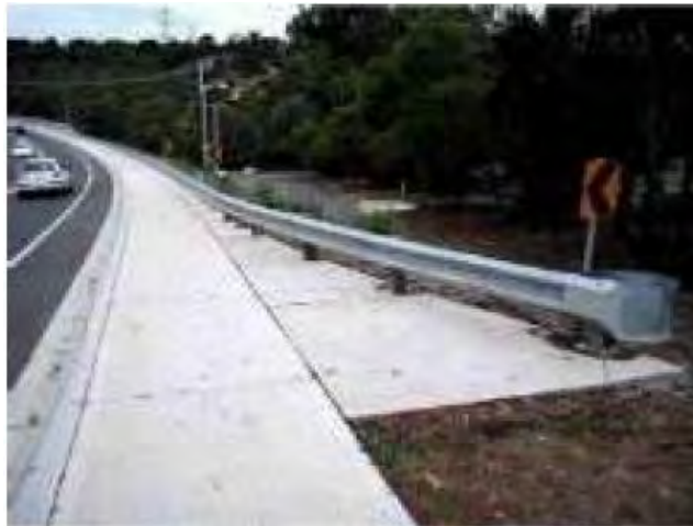
Figura 75. Terminal rompible acanalado de cable
