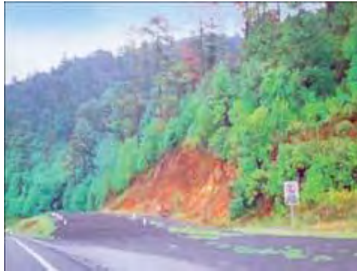
Figura 64. Rampa de frenado de emergencia
