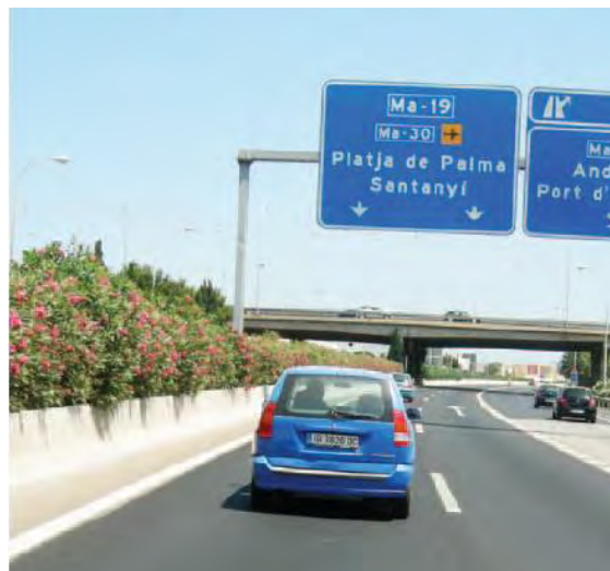
Figura 71. Barreras de hormigón con empradización
