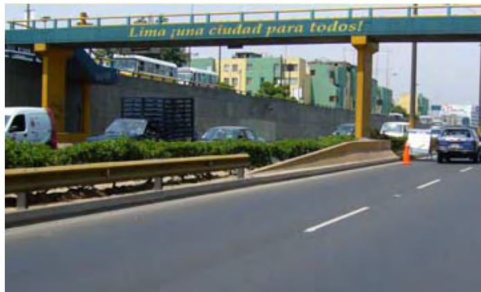
Figura 80. Ejemplo de una mala práctica: Guardavías no ensayados
