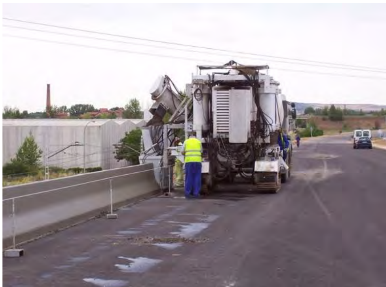
Figura 58. Detalle construcción barrera de hormigón
