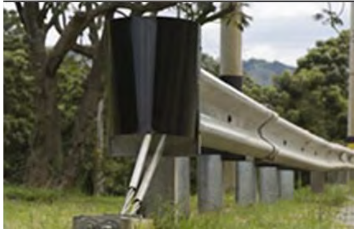
Figura 72. Barrera flexible de perfil “W”
