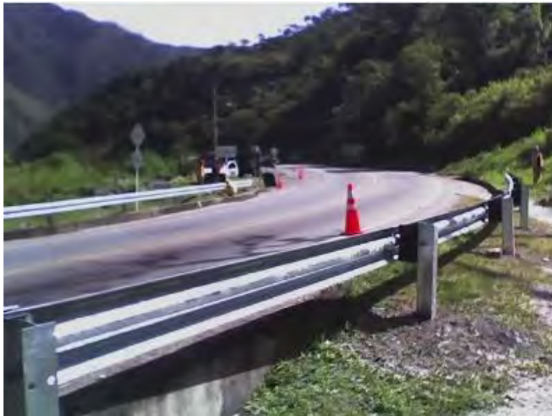
Figura 55. Defensa metálica con perfil “W”
