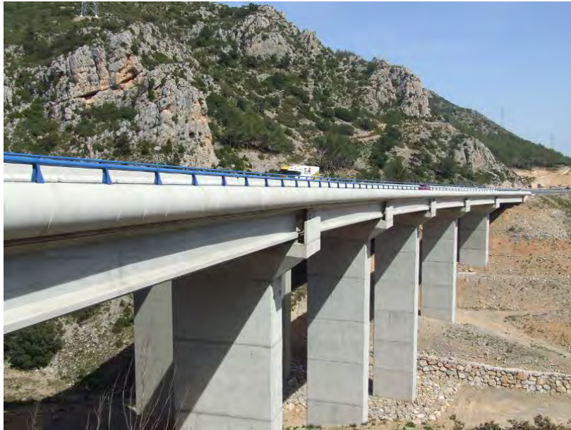
Figura 59. Barandal de protección
