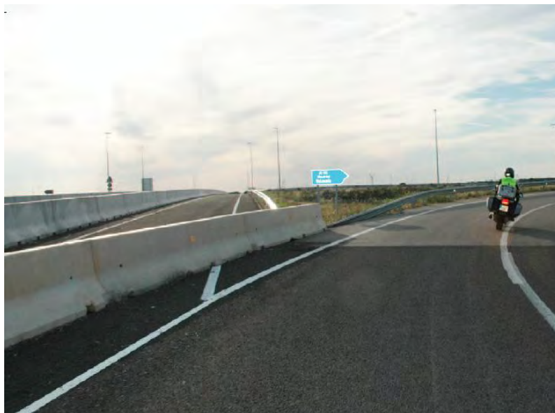
Figura 70. Barreras de hormigón combinada con barreras metálicas
