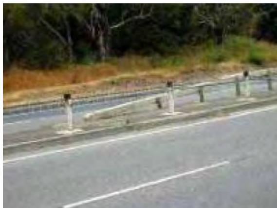
Figura 82. Barrera de cables de alambre usada como barrera de mediana y transición con barrera de agujero cuadrado
