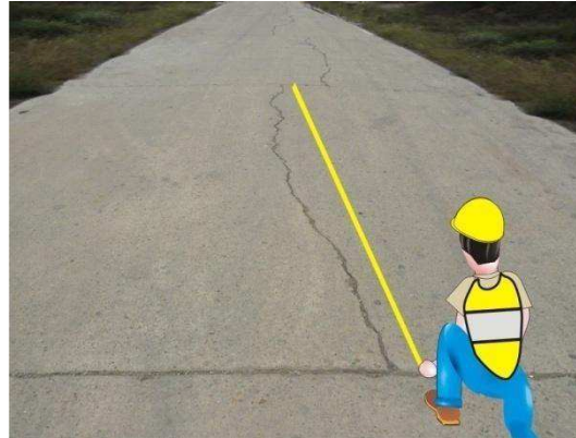
Figura 24. Grieta longitudinal 37
