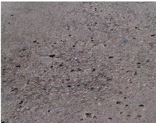
Figura 3. Pérdida parcial del agregado en tratamientos superficiales 15
