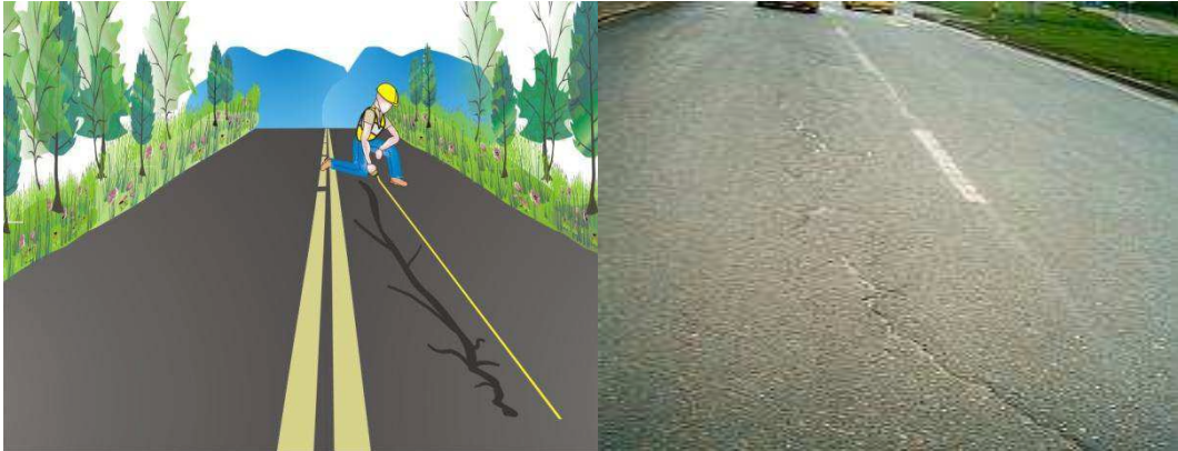
Figura 11. Grieta longitudinal 24
