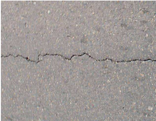
Figura 12. Grieta transversal 25
