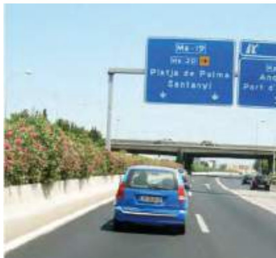
Figura 71. Barreras de hormigón con empradización
