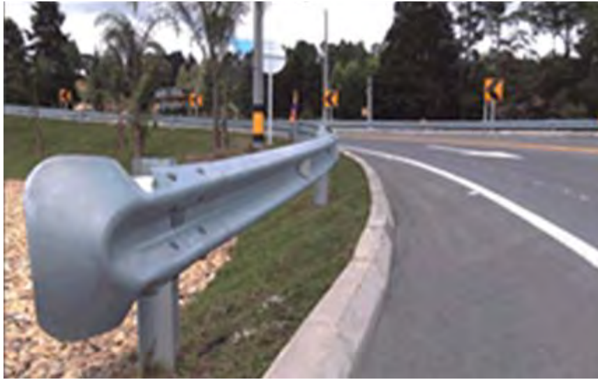
Figura 53. Defensa metálica con Delineadores de curva horizontal
