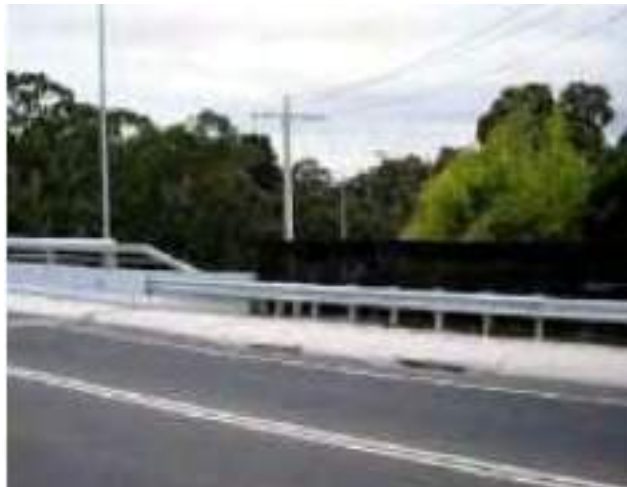
Figura 81. Transición desde barrera semirrígida (viga-W) hasta barrera rígida
