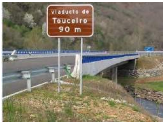
Figura 79. Transición desde barrera flexible a barrera de puente
