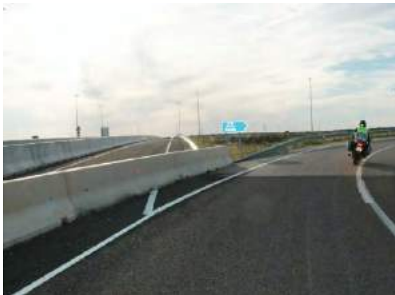
Figura 70. Barreras de hormigón combinada con barreras metálicas
