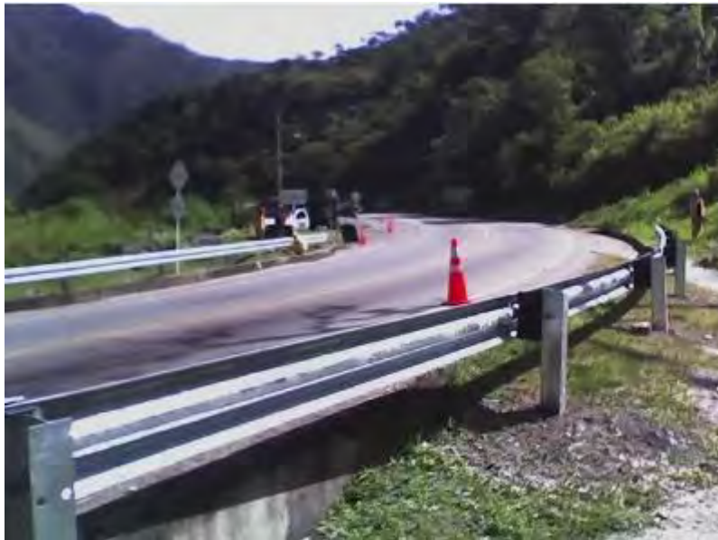
Figura 55. Defensa metálica con perfil “W”
