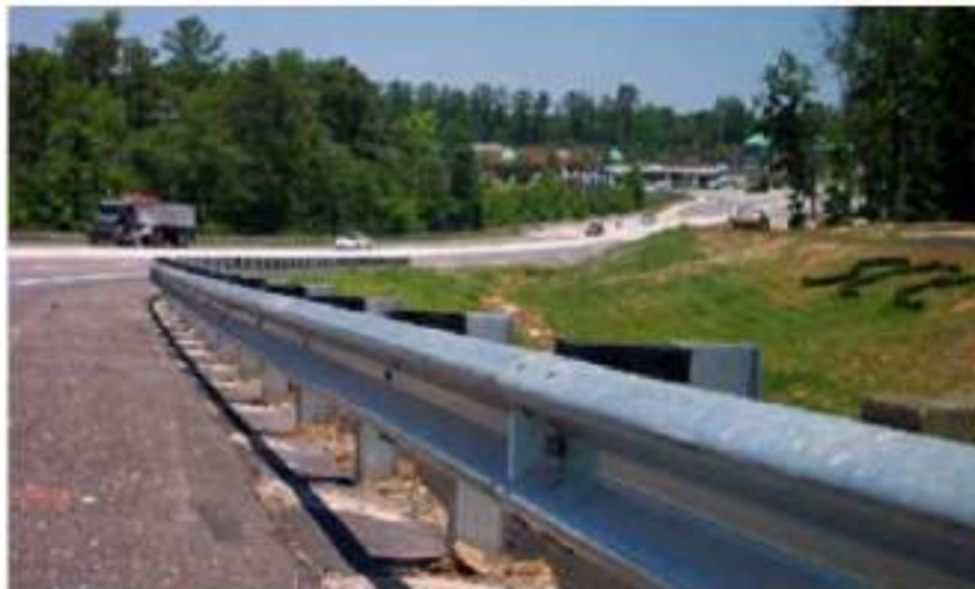
Figura 56. Defensa metálica típica
