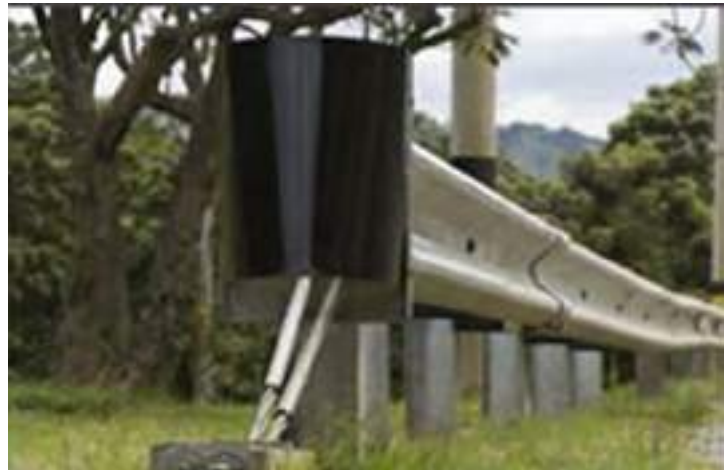
Figura 72. Barrera flexible de perfil “W”
