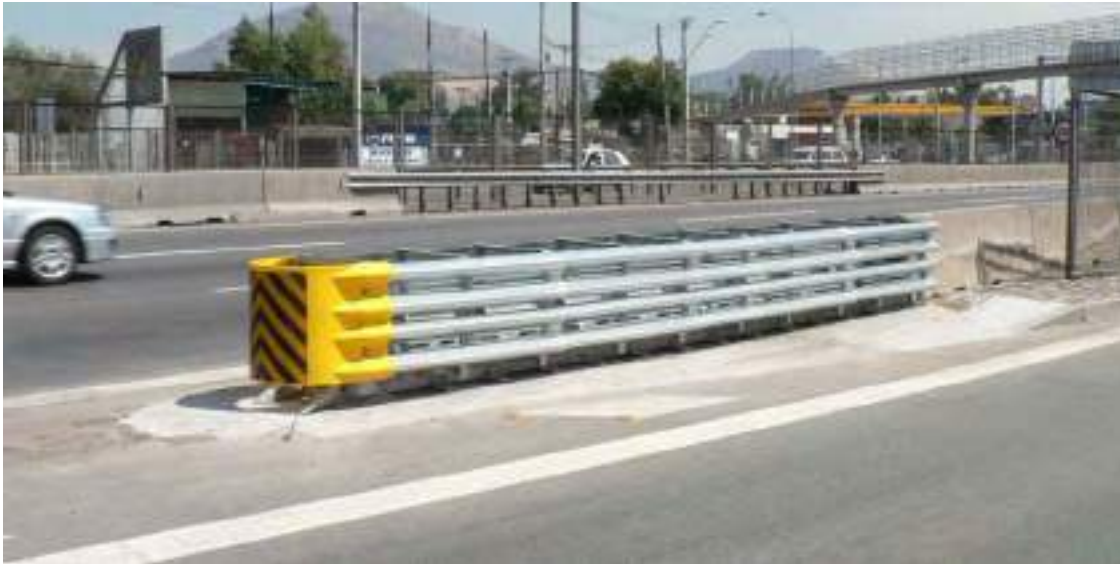
Figura 63. Amortiguador de impacto
