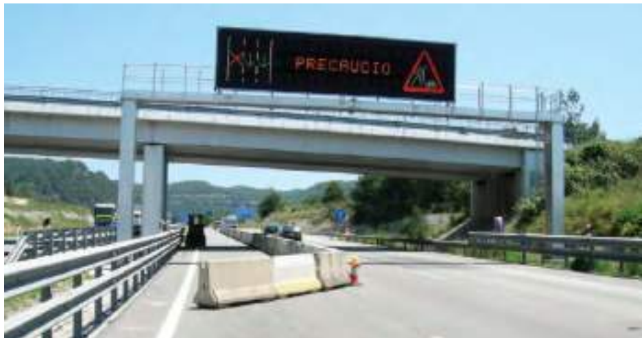
Figura 69. Defensas metálicas y barreras rígidas para canalización temporal del tráfico
