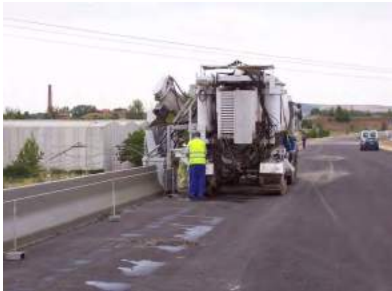
Figura 58. Detalle construcción barrera de hormigón
