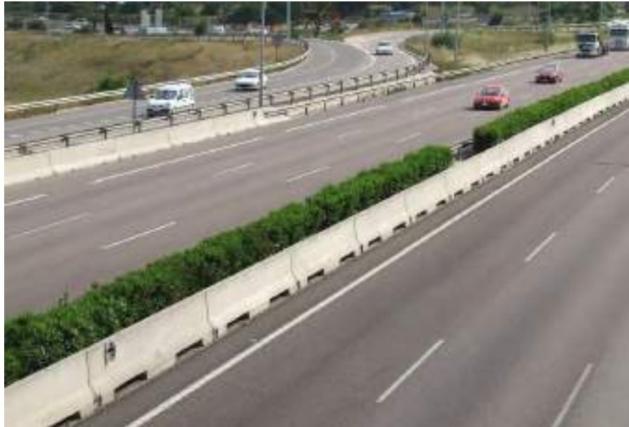
Figura 77. Barrera rígida de perfil de concreto
