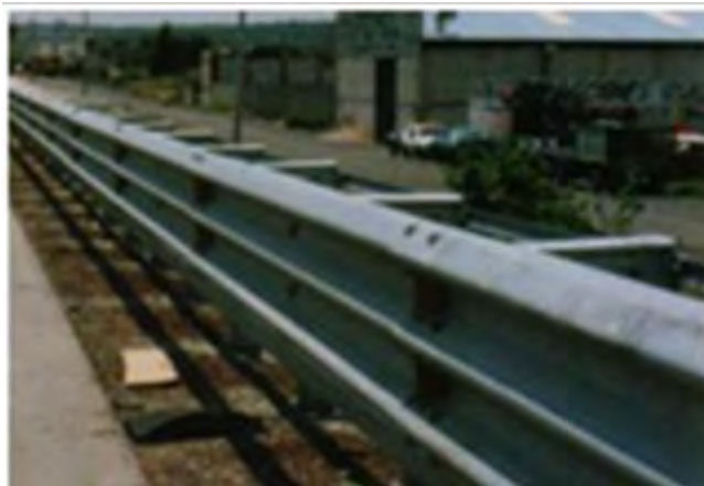
Figura 73. Barrera flexible de perfil triple onda
