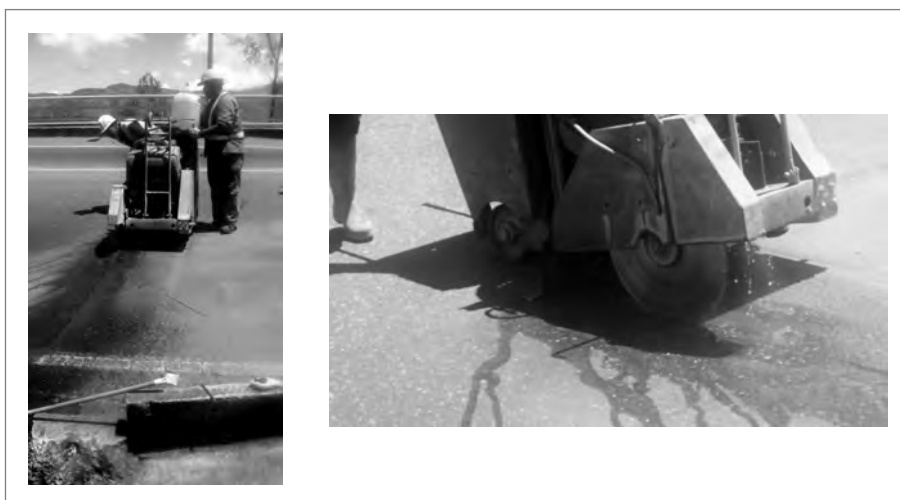
Figura 5. Cortes en el pavimento para la instalación de los Loop inductivos y cables piezoeléctricos
