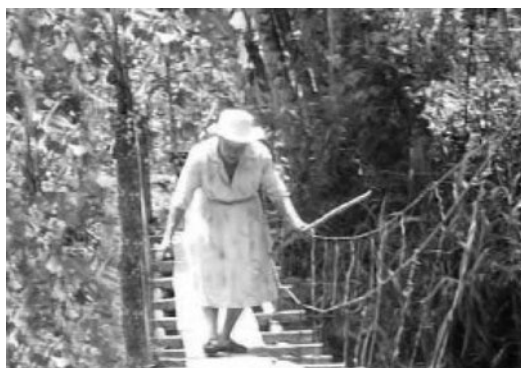
Figura 2. Puentes peatonales inadecuados en zonas rurales colombianas
