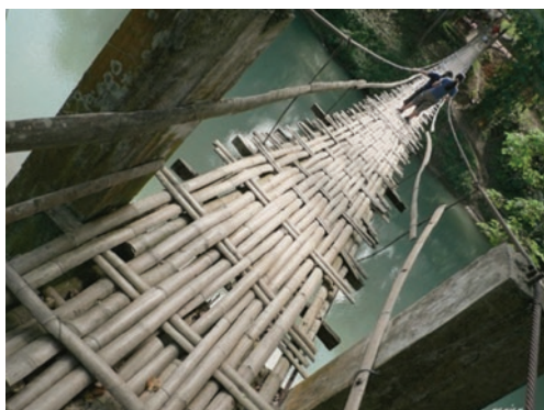
Figura 6. Puente en Bohol, Filipinas
