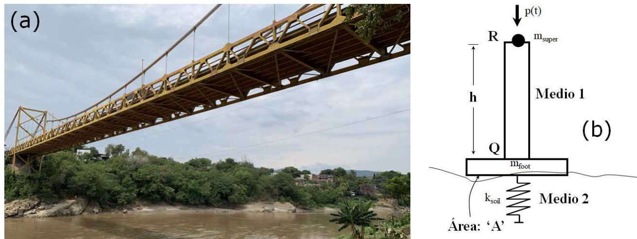
Fig. 1. (a) Puente estudiado; (b) Modelo propagación de ondas de la cimentación de un puente.
