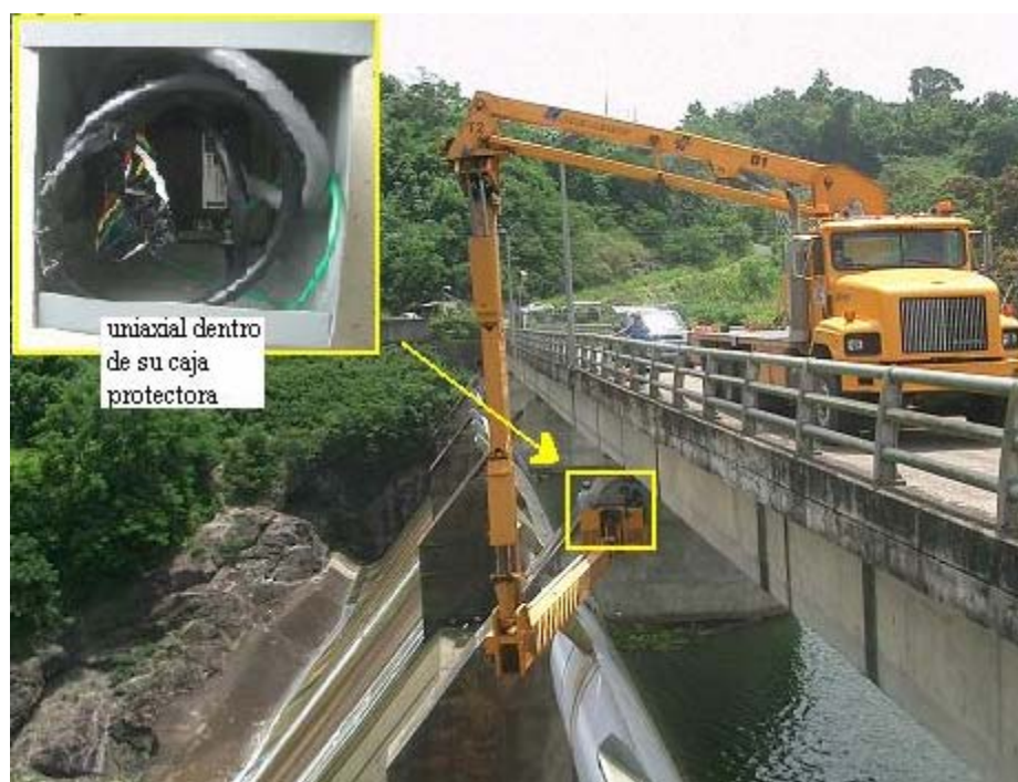
Figura 11-10: Instalación de acelerómetro sobre el apoyo del Puente con ayuda del snooper
