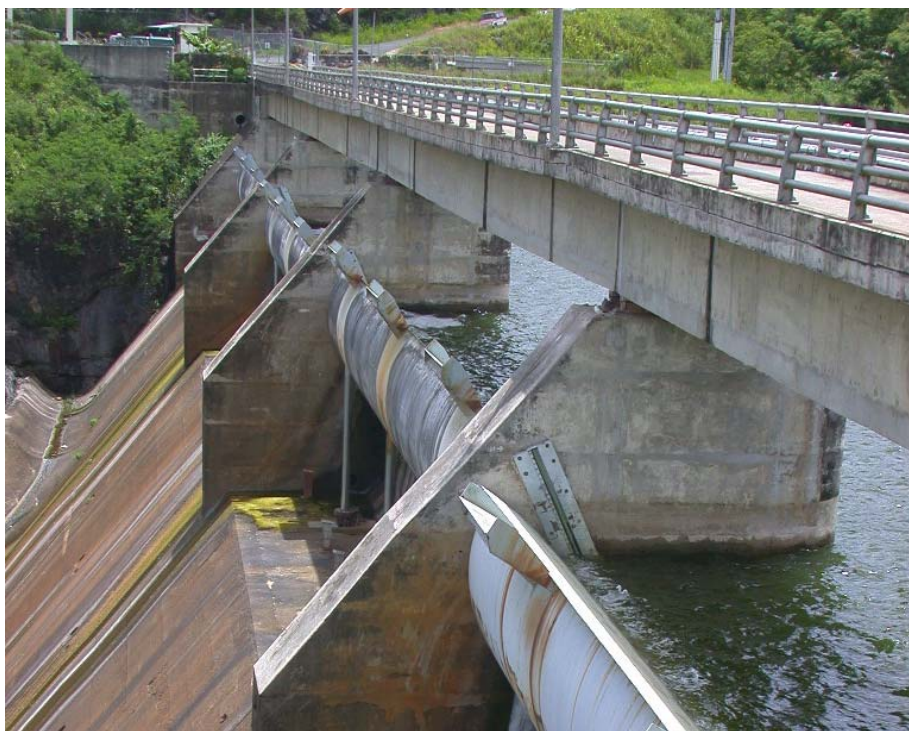
Figura 1-1: Cresta aguas abajo y puente, Represa La Plata, Toa Alta, PR.
