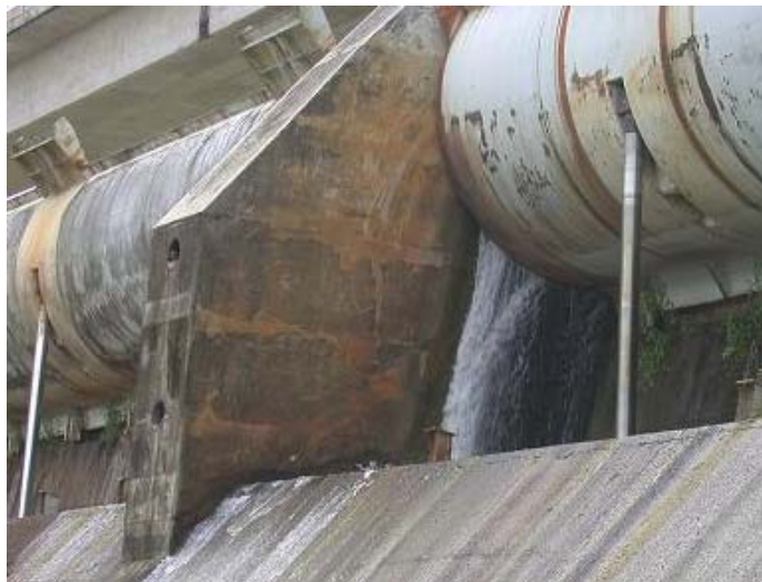
Figura 11-3: Báscula de salida con filtración. El agua va directo a las cámaras de pistones
