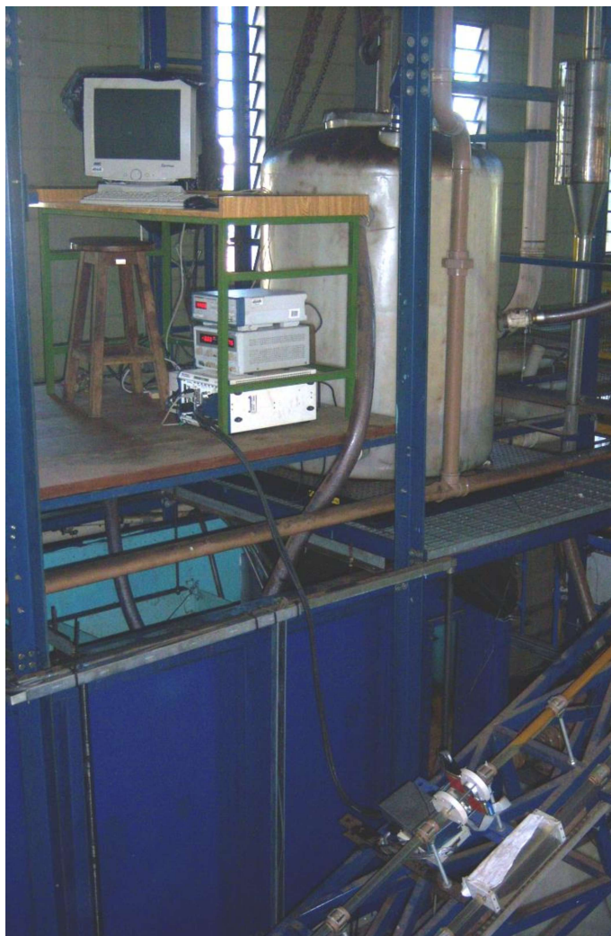
Figura 64. Fotografia do sistema WMT implementada na linha horizontal no NETeF.
