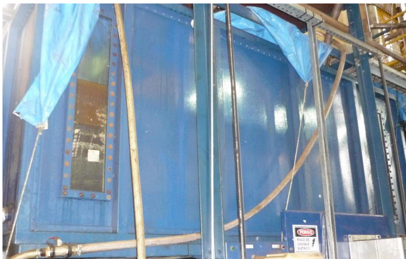
Figura 53. Separador de água e óleo do tipo placas coalescentes.
