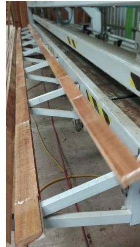
Imagen 28. Tiras de MAMW fresadas, pegadas y prensadas de 6 m de longitud.
