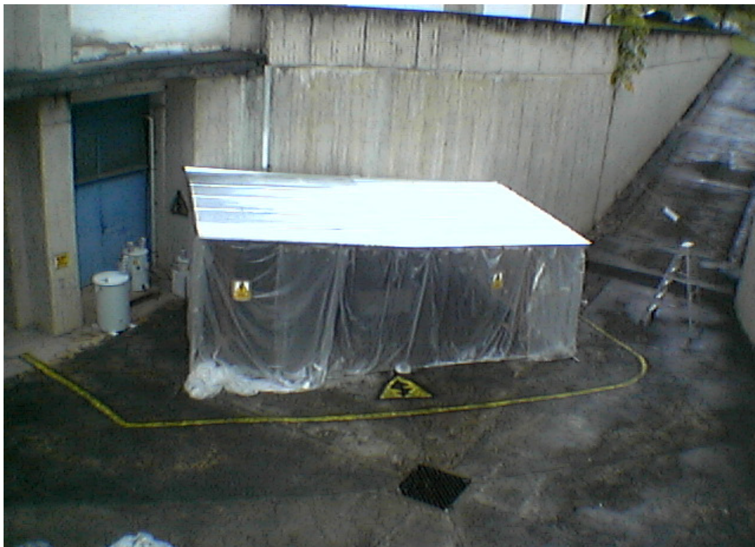
Fig. 12. Vista superior - Cámara Instalada
