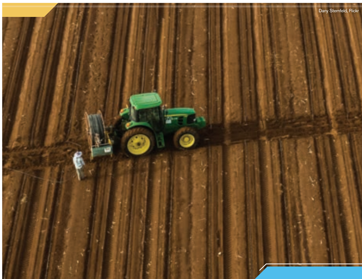
Laying irrigation lines in Ein Harod
