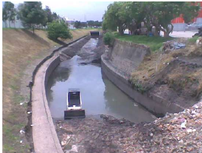
Fotografía 6-5. Acciones de limpieza en el canal de alivio hacia el canal Salitre con Carrera 68. Visita 13/03/2012.
