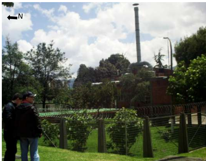
Fotografía 6-6. Vista del exterior de la Planta elevadora Salitre. Recorrido de campo 11/02/2012.
