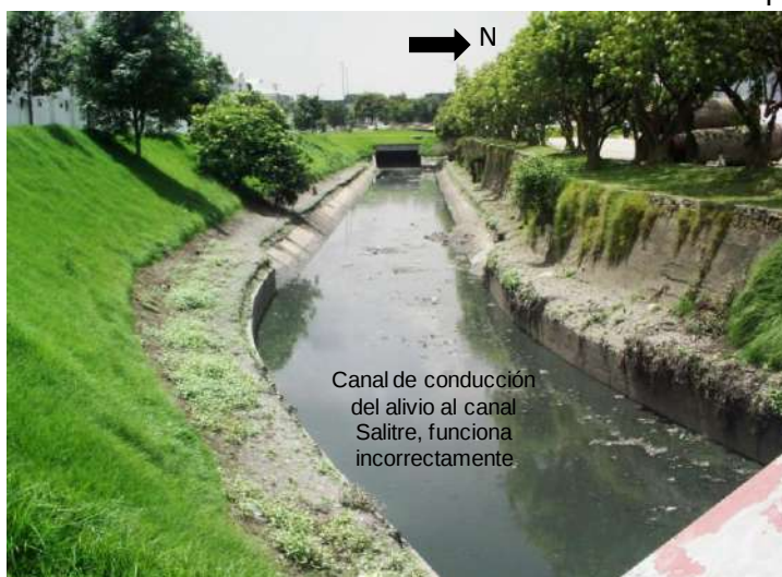
Fotografía 6-3. Alivio canal Salitre con Carrera 68. Recorrido de campo 11/02/2012.
