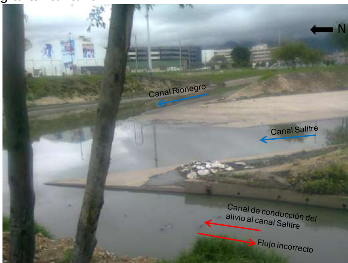
Fotografía 6-2. Canal Salitre en la confluencia con el canal Río Negro y el alivio de la Carrera 68. Fotografía 19/10/2011. EAAB.
