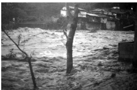
Fotografía 3. Viviendas en zona inundable
