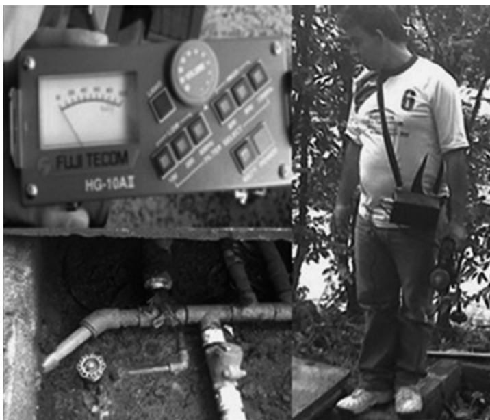
Fotografía 5.1. Campaña de localización de fugas con geófonos
