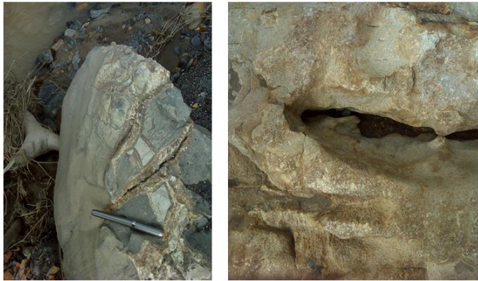
Figura 11. Discontinuidades y oquedades formadas en bloques de calizas que afloran en el sitio de estudio.
