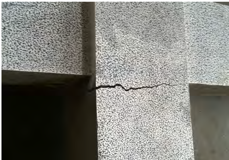
Figura 4.14. Detalle de la rotura generalizada en las caras de la columna de hormigón.
