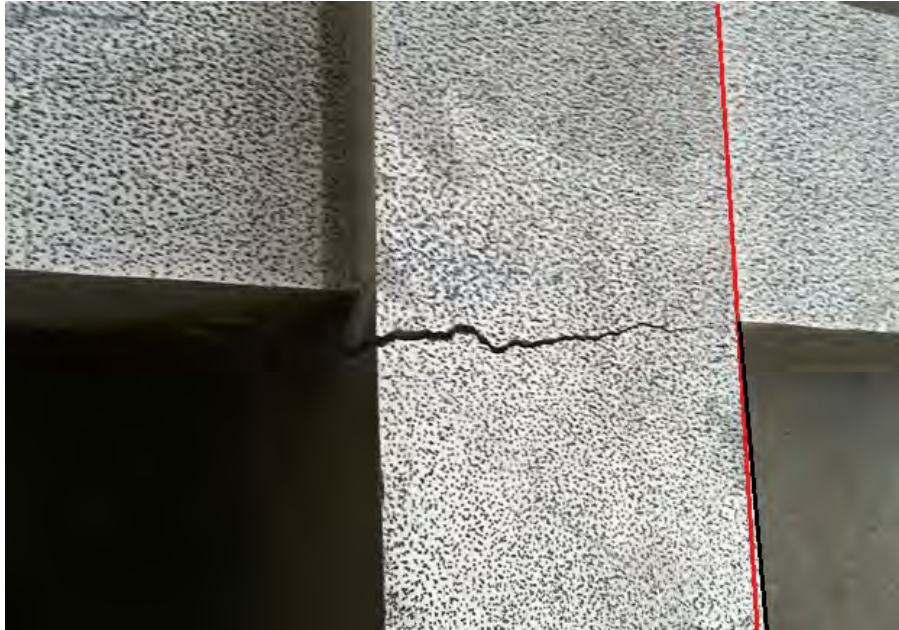
Figura 4.15. Detalle donde se observa la rotación post-colapso de la columna de hormigón.
