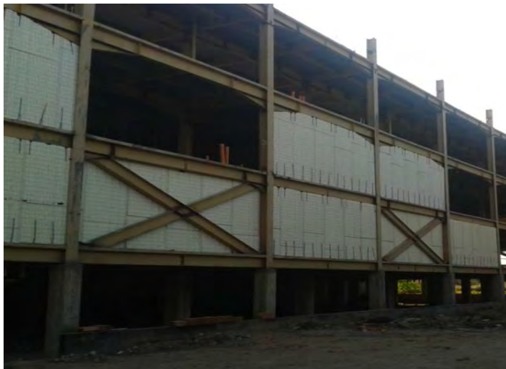
Figura 2.10. Vista externa de columnas de hormigón armado, vigas y losas de acero.
