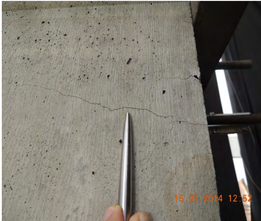
Figura 4.5. Detalle del inicio de las grietas en columna 1 de hormigón armado
