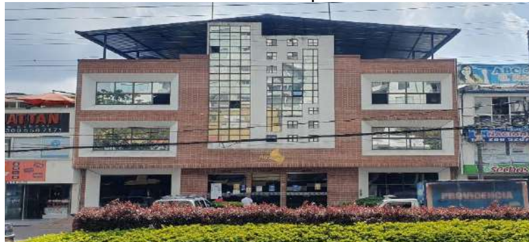
Figura 2–19: Edificio de oficinas de servicio público de Gas Alcanos de 3 Pisos.
