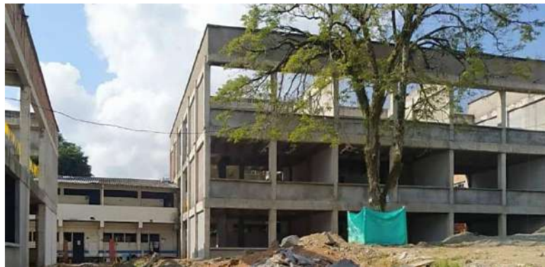
Figura 2–18: Institución educativa en construcción Colegio Arboleda Campestre de 3 Pisos.
