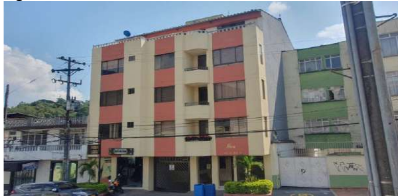
Figura 2–21: Edificio residencial de 5 Pisos en Barrio Belén.
