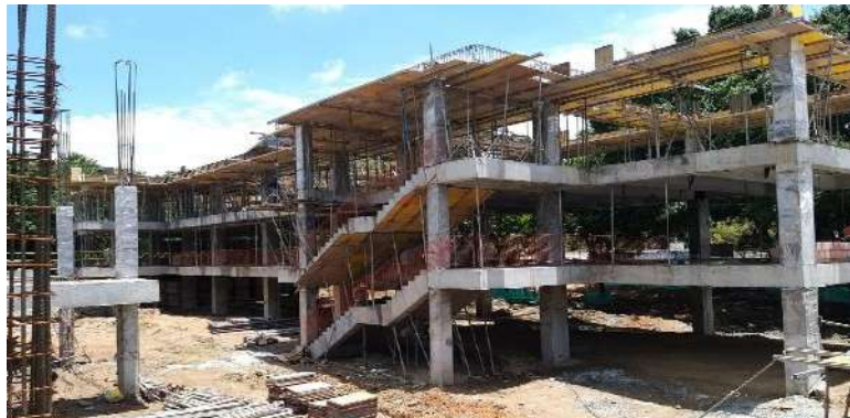
Figura 2–16: Institución educativa en construcción Colegio la Sagrada Familia de 3 Pisos.
