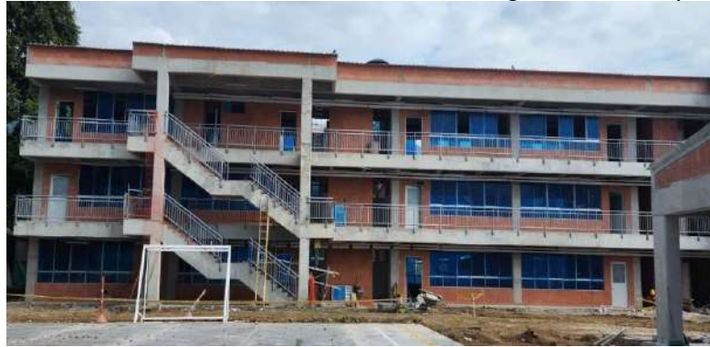
Figura 2–20: Institución educativa en construcción Colegio Normal Superior de 3 Pisos.
