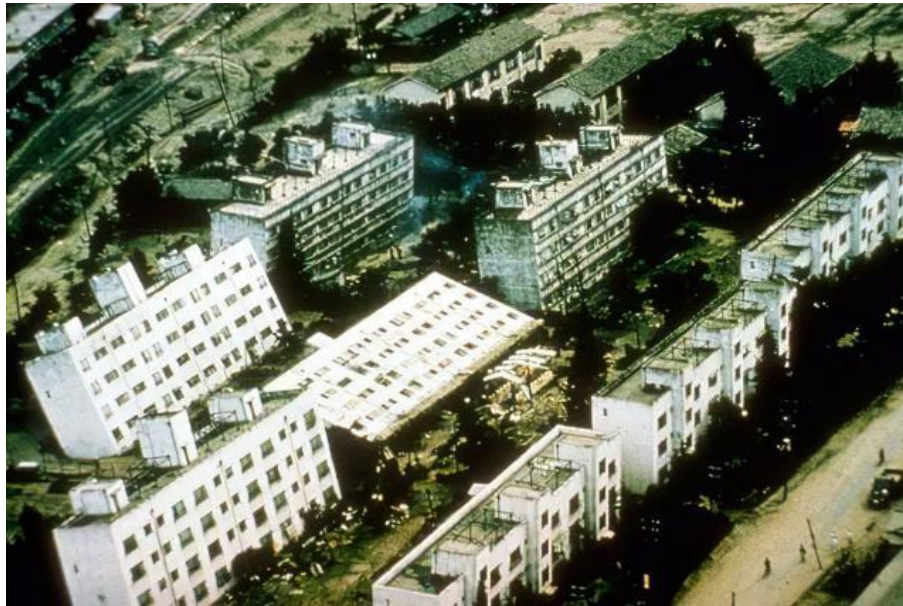
Figura 1. Daños en el conjunto habitacional de apartamentos en Kawagishi-cho, durante el terremoto de Niigata en 1964.
