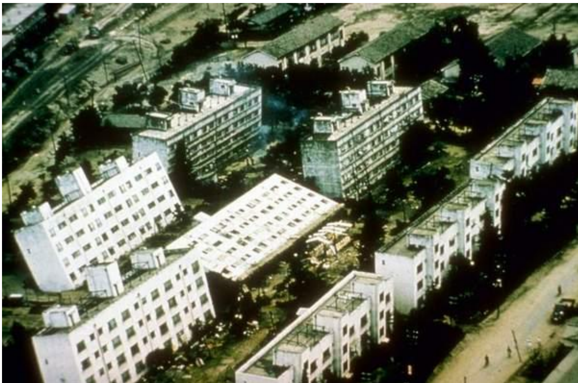
Figura 1. Licuación del suelo durante el terremoto de Niigata, Japón en 1964.
