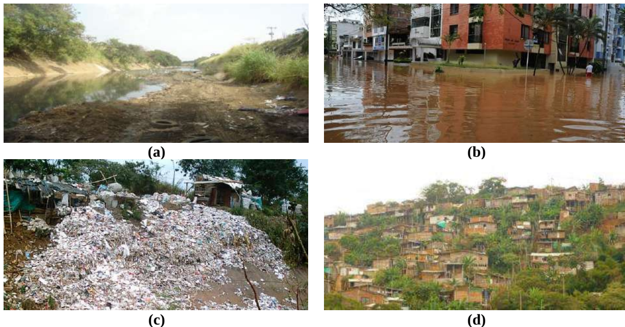
Figura 5.4 Problemas asociados a la gestión inadecuada del drenaje urbano del SDS de Cali (a) Sedimentos en el Canal Sur; (b) Inundación en la cuenca baja del río Meléndez sector El Ingenio; (c) Residuos sólidos en el Canal Sur; y (d) Asentamientos informales en la cuenca alta del río Meléndez sector Las Palmas
