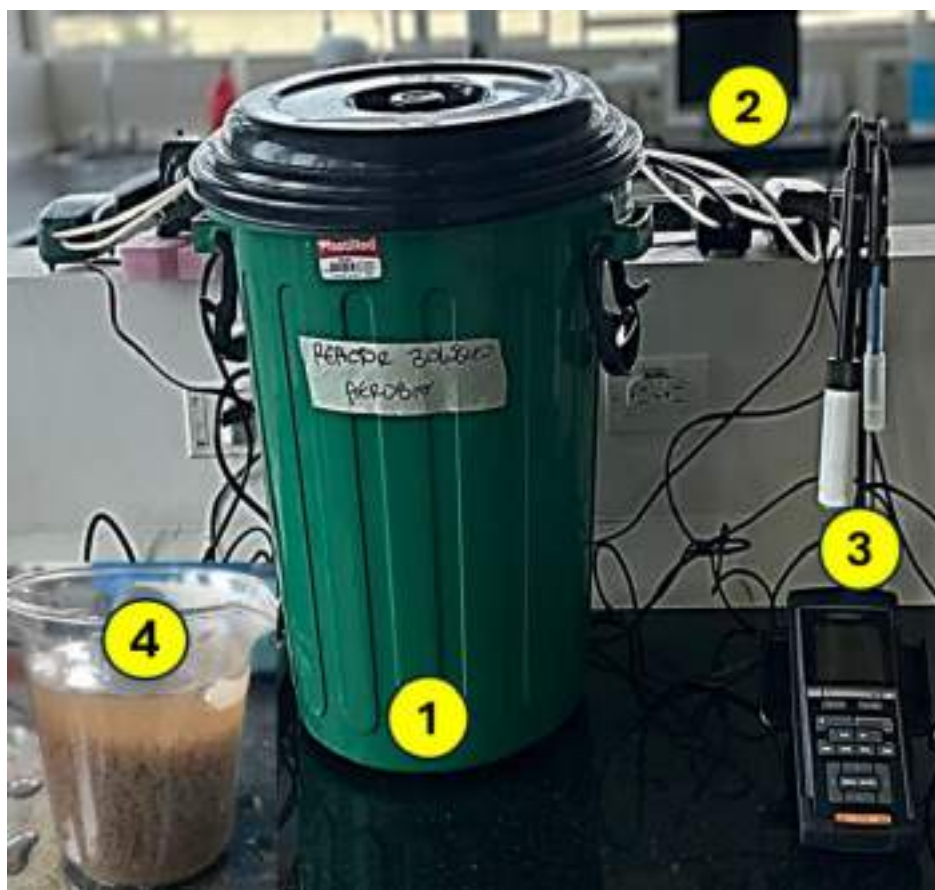
1. Tanque reactor biológico; 2. Entrada de aire; 3. Control parámetros; 4. Muestra lodo Figura 19. Reactor madre escala laboratorio de lodos activados.
