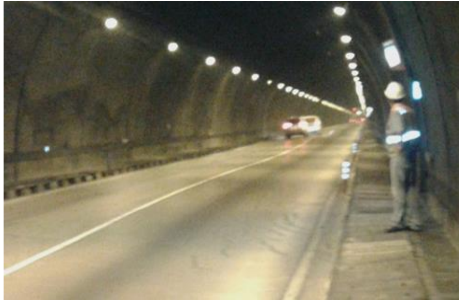
Figura 1.4: Deformación excesiva y patrón de falla en 2017.
