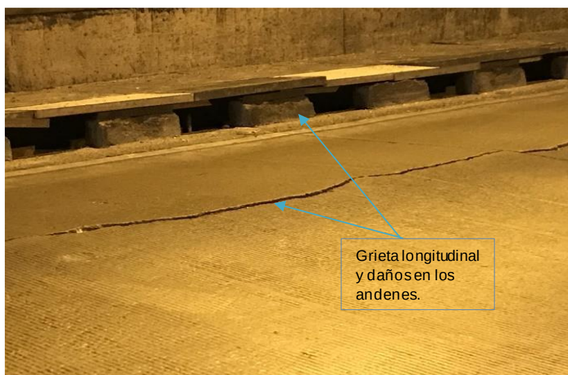
Figura 4.21: Grieta longitudinal
