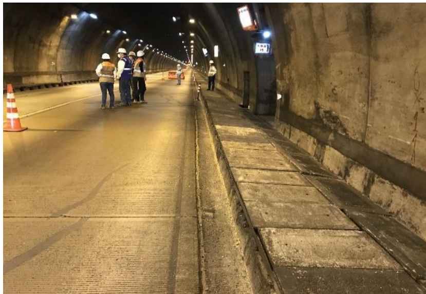
Figura 4.20: Levantamiento de las losas de los andenes
