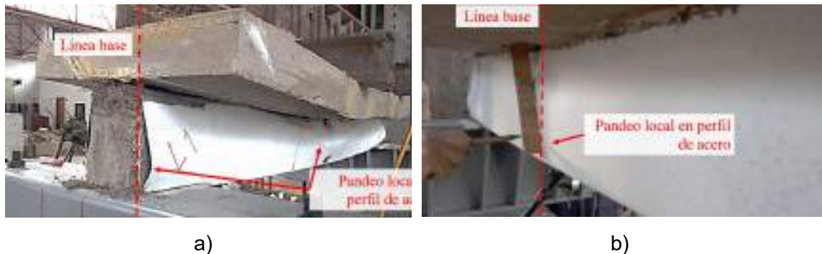
Figura 2-21: Pandeo local en viga de acero en ensayo experimental de vigas compuestas con tornillos como fijación de conectores. a) Vista general. b) Detalle lateral de la platina.
