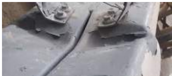
Figura 2-23: Estado final del sistema de fijación con tornillos autoperforantes en ensayo experimental de vigas compuestas con tornillos como fijación de conectores.
