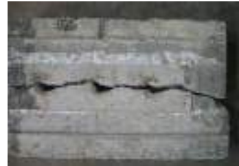
Falla del concreto
