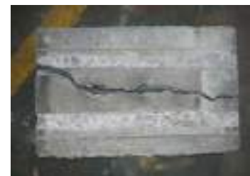
Falla del concreto
