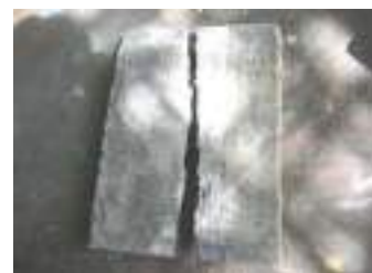
Falla del concreto
