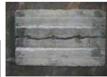
Falla del concreto
