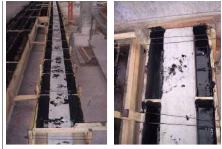
Figura 2.12 Formaleta impregnada de aceite quemado.
